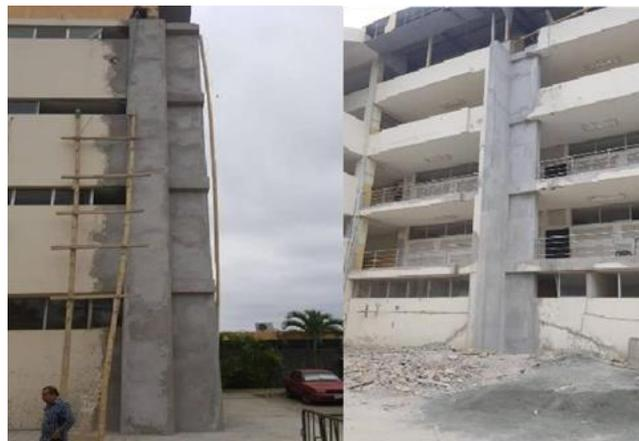
**Figura 3:** Reforzamiento aplicando muros de corte en un edificio de hormigón armado
