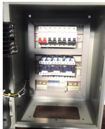
Figura 17: Montaje de los breakeres del panel de control
