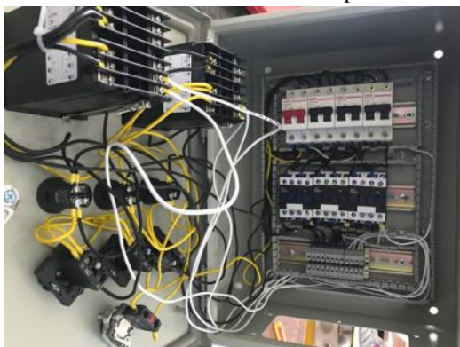
Figura 16: Tablero de control de la máquina extrusora
