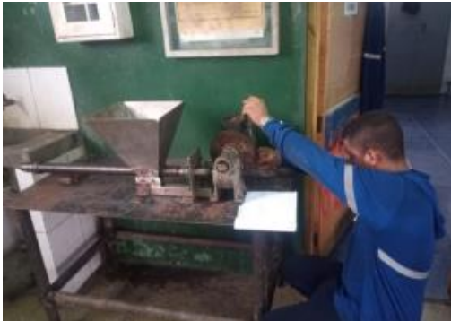
Figura 14: Comprobación entre la altura del motor y la base de soporte
